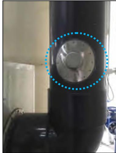
臭气治理装置进口采样孔实景图片
